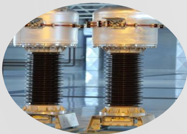
Трансформаторы тока элегазовые с фарфоровой изоляцией (ТОГФ)
