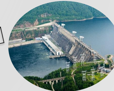
Поставка электрооборудования для Курпайской ГЭС
