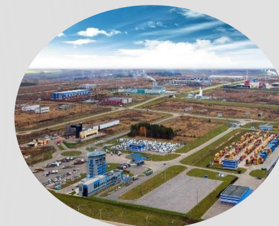
Создание энергораспределительной подстанции в ОЭЗ ППТ Алабуга
