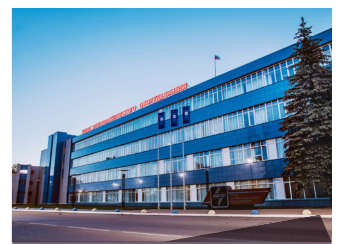
Промышленный технопарк "Электрополис"
